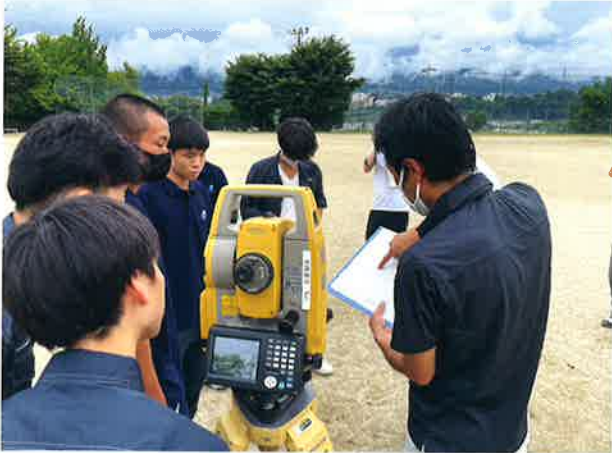
道路中心線の設置風景
