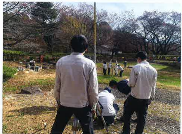
横断測量実施状況
