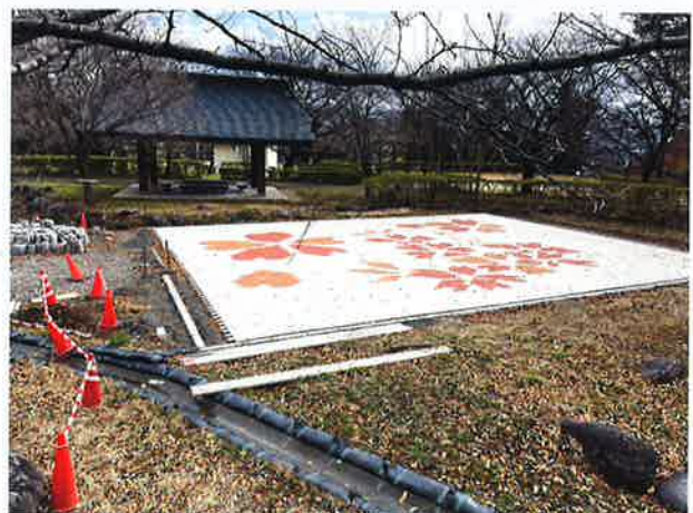
インターロッキング敷設と水路工事中!
